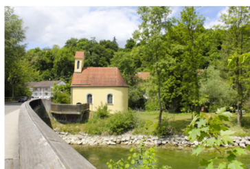
St. Nikolauskapelle an der Amper
