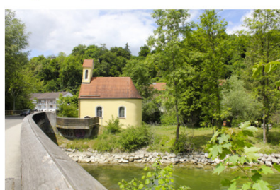
St. Nikolauskapelle an der Amper
