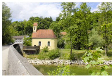
St. Nikolauskapelle an der Amper
